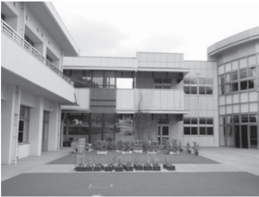
耐震改修増築された南阿蘇村立南阿蘇西小学校
