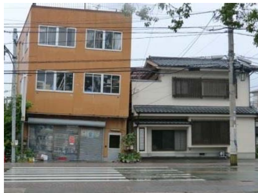
図 液状化による建築物の傾斜
