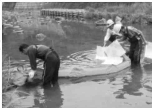
▲オイルフェンスと吸着マットで流出した油を回収
