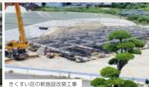
きくすい荘の新施設改築工事
