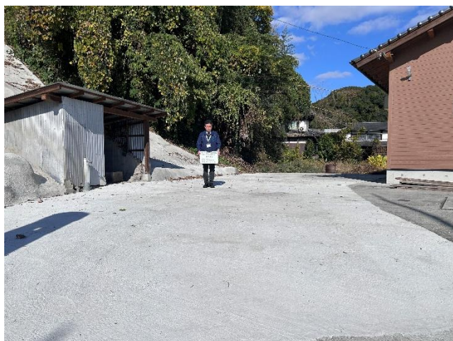
(内田区詰所前コンクリート舗装工事)
