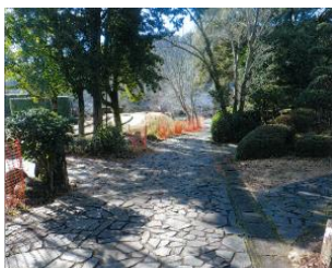
舗装工事 着工前
