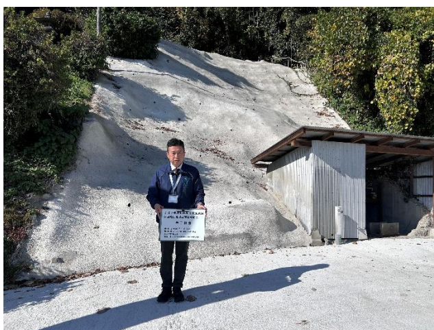
(内田区詰所前法面モルタル吹付工事)
