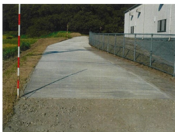
コンクリート舗装
