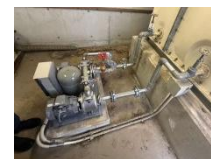
加圧ポンプ取替後
