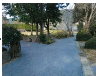
舗装工事 竣工
