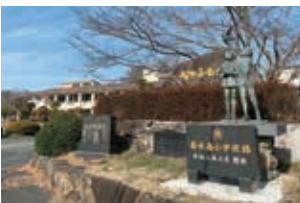
旧菊水南小学校。令和7年12月25日で町へ所有者移転完了。
