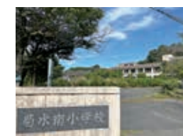
旧南小学校。令和10年1月工場稼働予定。
