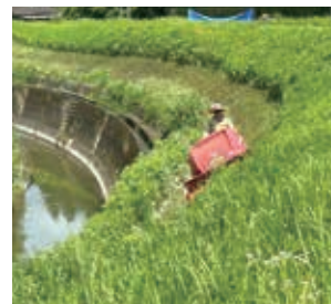
県河川堤防法面除草作業
