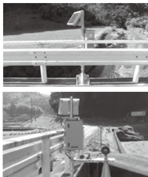
日平川畑上橋水位計の設置状況
