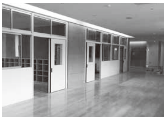
増築校舎内部
