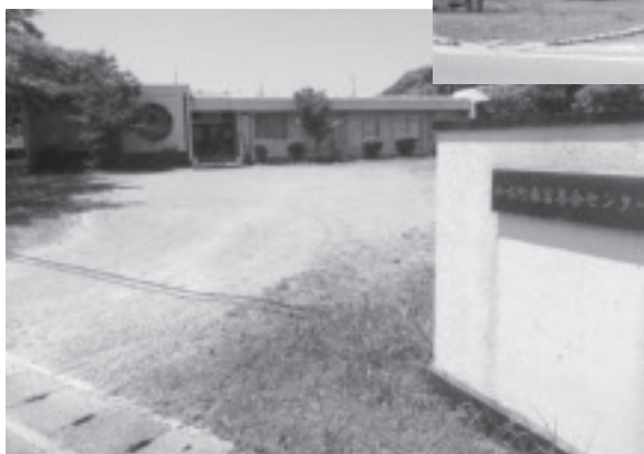
春富地区住民の拠点施設『春富集会センター』
