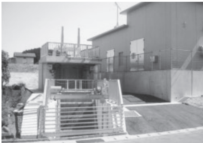
防災対策『江栗排水機場』(3月完成)
