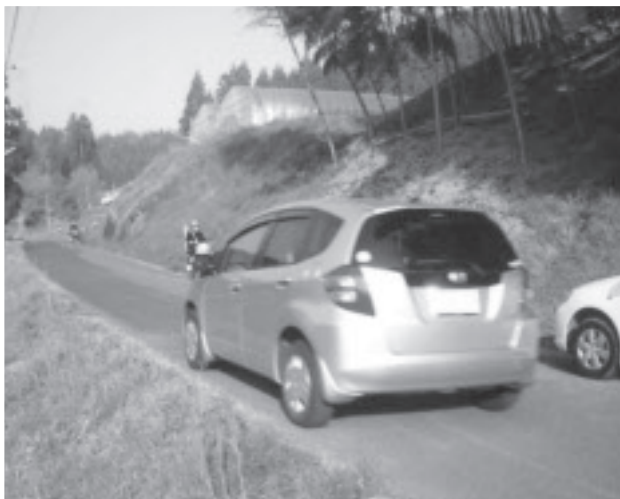
改良・拡幅が求められている町道『西光寺中林線』
