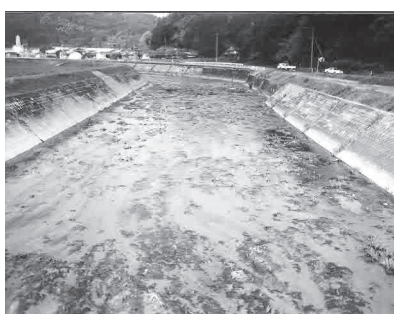
和仁側河川葦抜根状況(大田黒地区)
