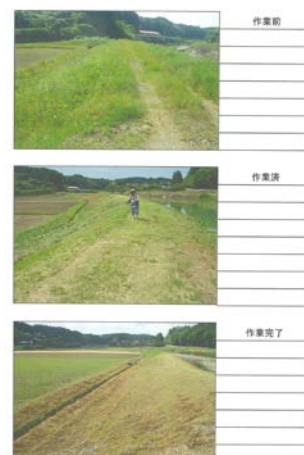
美化作業前 ～ 作業後
