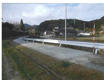
コンクリート舗装
