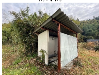
除却前 旧緑中公衆トイレ
