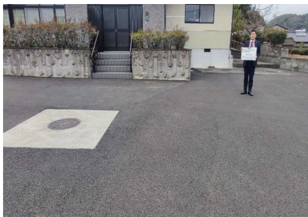
(内田区自治会館舗装工事)
