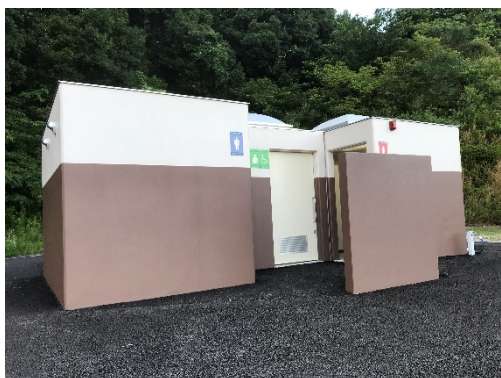
新設した公衆トイレ
