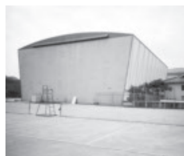
改修が計画されている三加和中体育館
