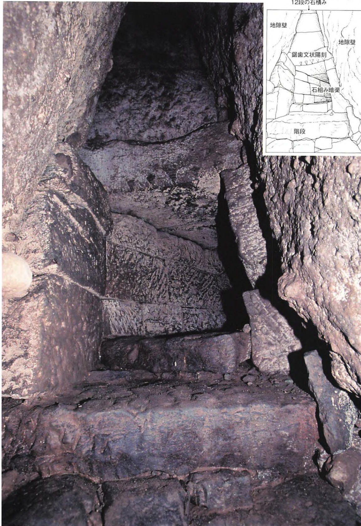
石組み暗渠入口（C箇所） 12段の石積みと、石組み暗渠の天井石に陽刻された鋸歯文状文様
