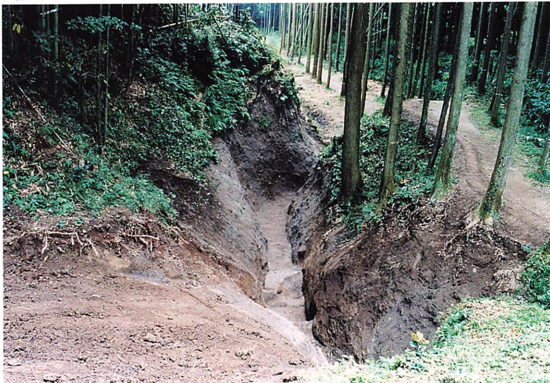
D-E区間（上場幅が広く、深い地隙）
