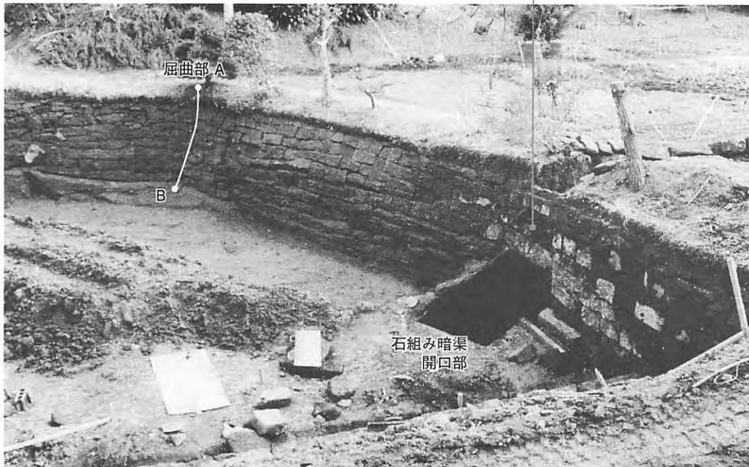
図版41 L箇所 石垣 (平成12年2月調査)
