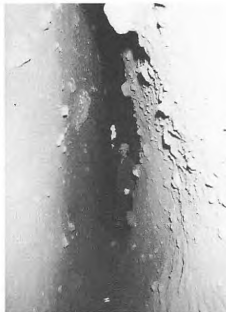
図版25 第2地隙内部 (E-F区間)
