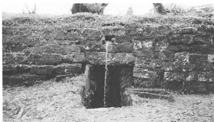
図版44 湧水が石組み小暗渠を流れてL箇所の開口部に落ちる
