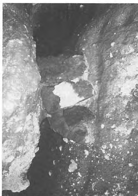
図版33 第2 トンカラリンの現存天井石
