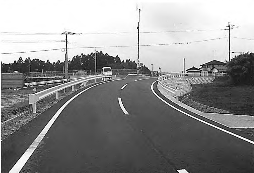
道路改良工事完成（東から）
