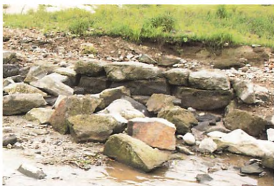
II 区 石積み (河川側から)
