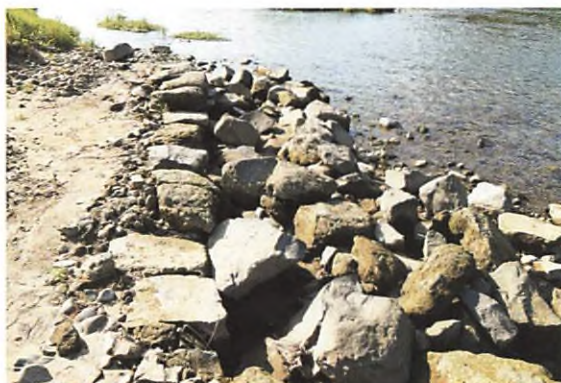
II 区 石積み (上流から)
