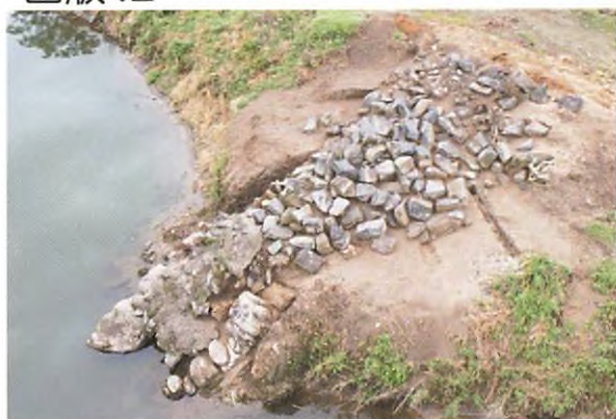
I 区 全景 (下流から)
