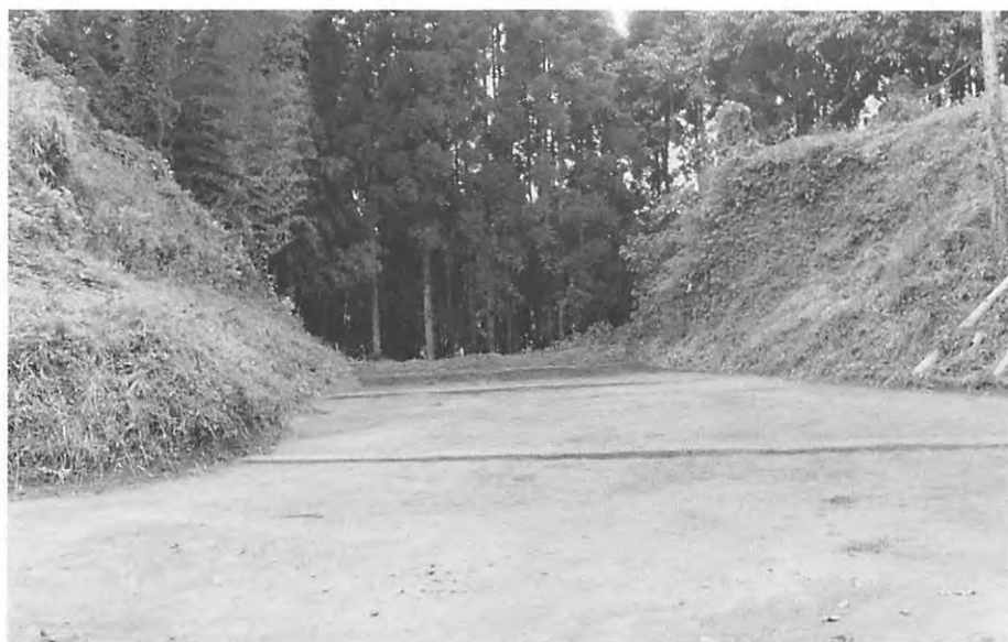
(2) 表土剥ぎ終了状況（北より）
