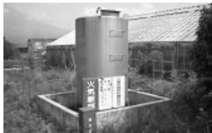
燃料タンク(少量危険物貯蔵・取扱所)で油を貯蔵・取扱う場合は、火災予防条例で、設置基準や消防本部へ届出の義務があり、危険物が漏れた場合にその流出を防止するための有効な措置を講ずることになっています。その対策としてタンクの周囲に「防油堤」を設ける方法があります。油流出の防止策として必ず設置してください。事故が発生してからでは手遅れですので、基準にあった施設の設置を行ってください。また、消防本部への届出もお願いします。
