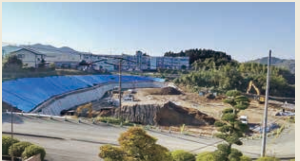
敷地造成工事の状況(敷地北側より撮影)
