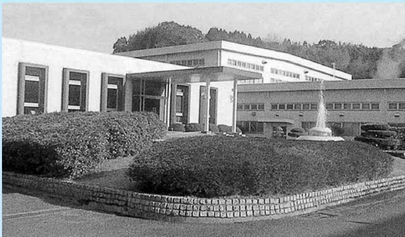
(熊本工場の全景)
