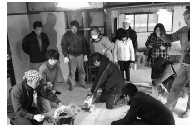
地元職人による釘打ち体験の様子
