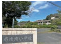
旧南小学校。令和10年1月工場稼働予定。
